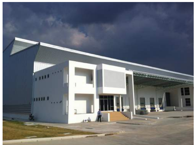
โครงการ T-Park นิคมฯ เหมราช จ.ชลบุรี
